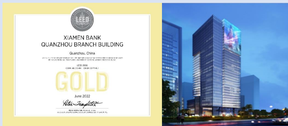
图 7-8：厦门银行泉州分行大厦取得 LEED 金级认证
